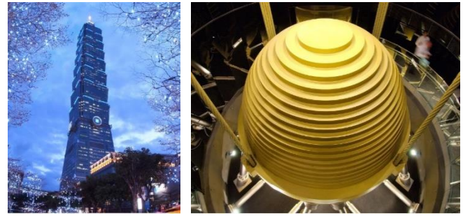
Hình 2. Toà tháp Taipei 101 và hệ thống con lắc giảm chấn chủ động nặng 660 tấn.
